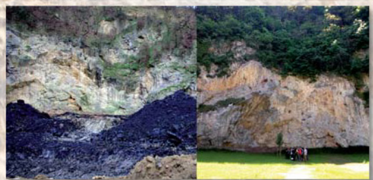
Stav pred a po sanácii EZ Devínska Nová Ves – kameňolom Srdce (foto Róbert Hovorič, Lubomír Jurkovič)
