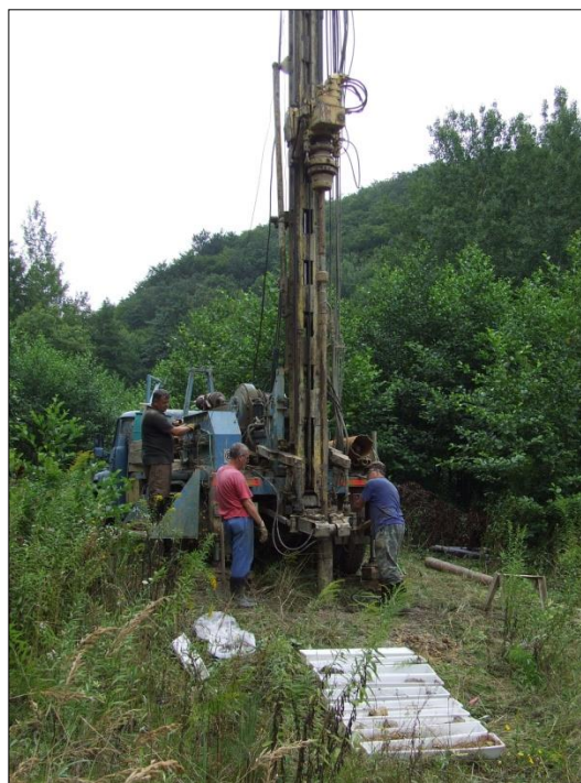
Obr. 46: Súprava WIRTH B1 pri realizácii vrtovej PONV-5 (areál bývalého banského závodu) a vrtovej PONV-9 v odkalisku v Petrovej doline
