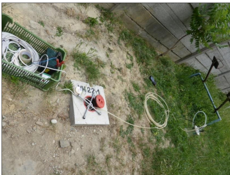
Obr. 27: Ukážka zabudovania monitorovacieho vrtu na úrovni terénu a odberu vzorky vody
