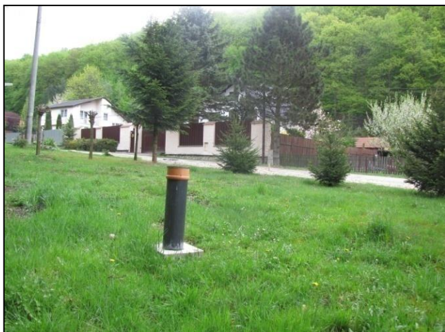
Obr. 57: Hydrogeologický vrt POHG-6, potenciálny vrt pre monitoring podzemných vôd
