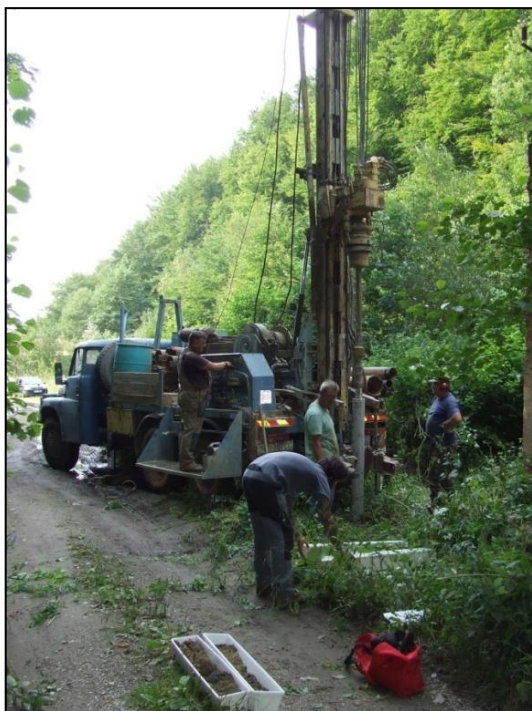
Obr. 46: Súprava WIRTH B1 pri realizácii vrtovej PONV-5 (areál bývalého banského závodu) a vrtovej PONV-9 v odkalisku v Petrovej doline
